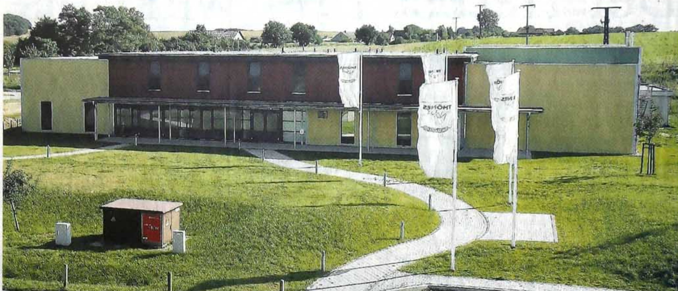
Unmittelbar vor Deutschlands größter Feldsteinscheune wurden in Bollewick die Landwerkstätten errichtet. Am 7. Oktober nimmt hier der Thönes-Natur-Verbund den Schlacht- und Verarbeitungsbetrieb auf.
